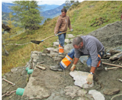
Die beiden Baumeister bei der Handarbeit an der Stützmauer der Engelhornhütte
