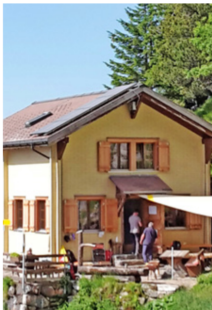
Die neue Solaranlage auf dem Dach der Hütte
