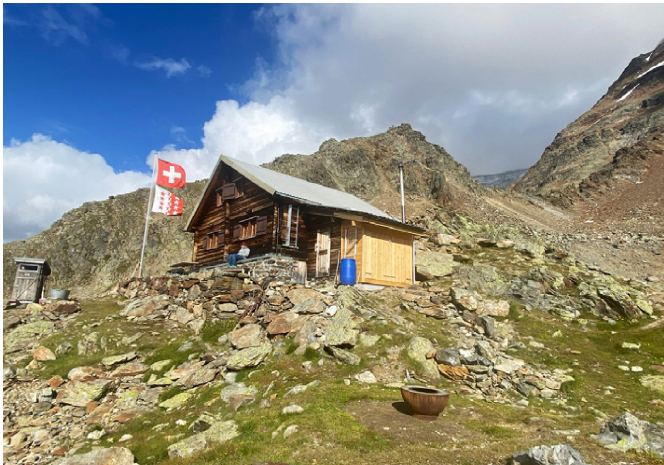
Die Bietschhornhütte mit dem neuen Schopf
